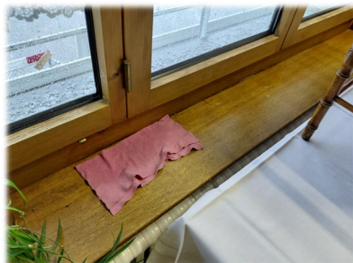
undichtes Fenster
